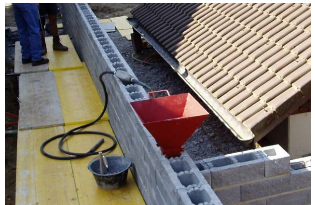
Bild 50: Einbringen von Füllbeton mit einem geeigneten Trichter
