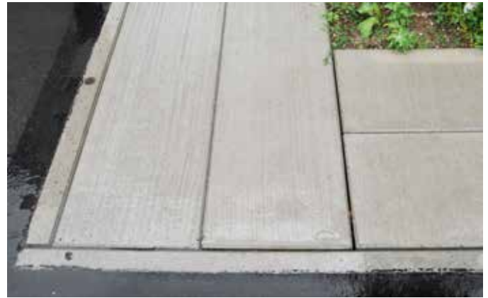
Wasserzufuhr durch Fugen
