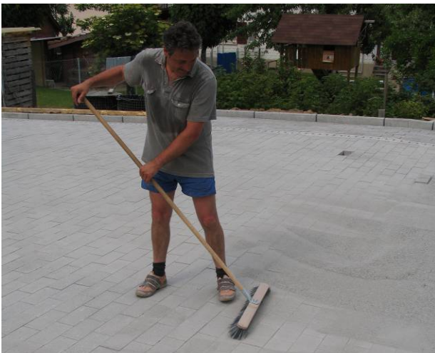
Bild 37: Einsanden der Fugen
