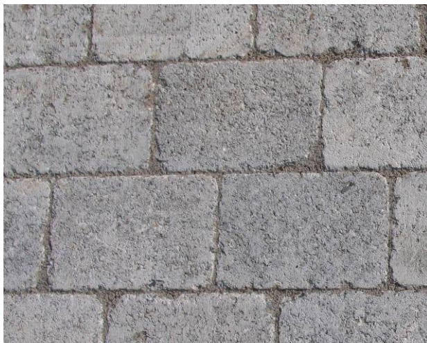
Bild 34: Optimale Fugen bei TEGULA® Pflastersteinen
