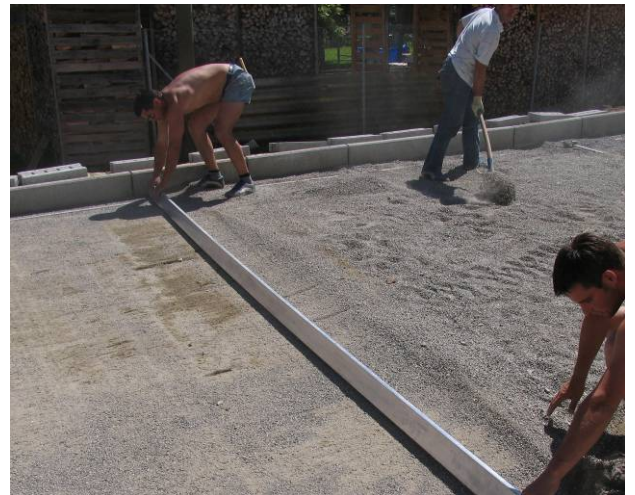
Bild 33: Abziehen der Bettungsschicht
