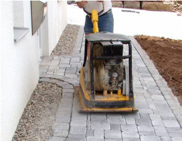
Bild 36: Abrütteln der Pflasterfläche
