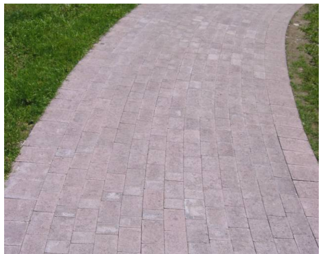
Bild 3: TEGULA® Pflastersteine porphyr, vollkantig
