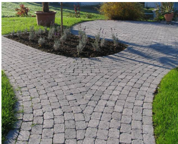
Bild 41: Pflasterfläche mit Passsteinen
