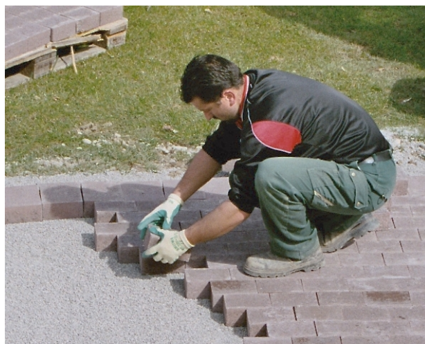
Bild 35: Verlegung der Steine von Hand
