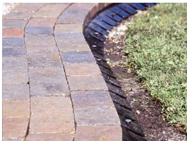
Bild 44: Randabschluss mit PAVE EDGE Randschienen
