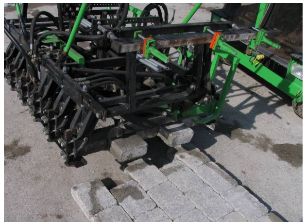
Bild 39: Maschinelle Verlegung mit OPTIMAS Verlegemaschine
