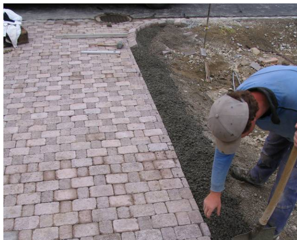
Bild 43: Erstellen des Randabschlusses
