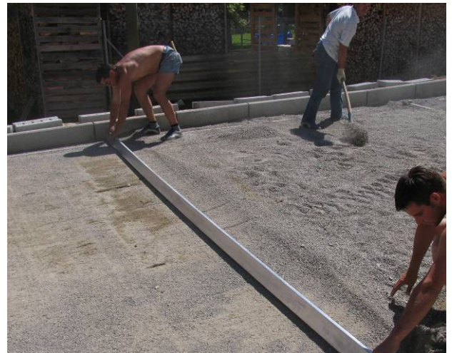
Bild 33: Abziehen der Bettungsschicht
