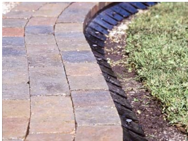
Bild 44: Randabschluss mit PAVE EDGE Randschienen
