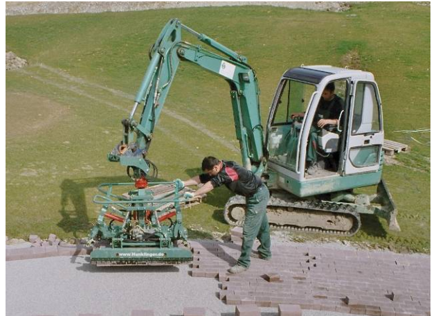
Bild 38: Verlegemaschine im Einsatz
