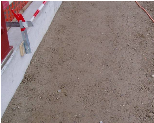
Bild 32: Eingebaute verdichtete Fundationsschicht
