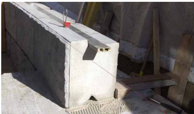
Bild 23 Streifenfundament mit Klebemörteldünnschicht
