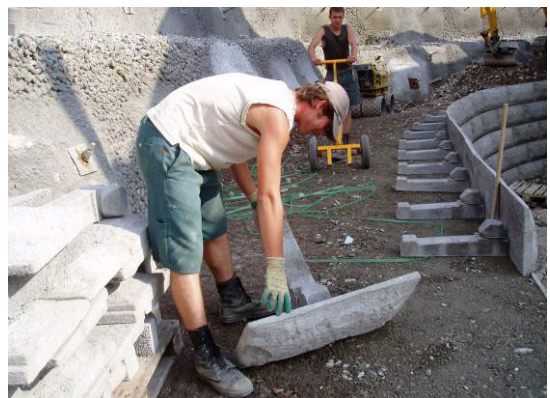
Bild 16: Frontplatte mit Anker verbinden
