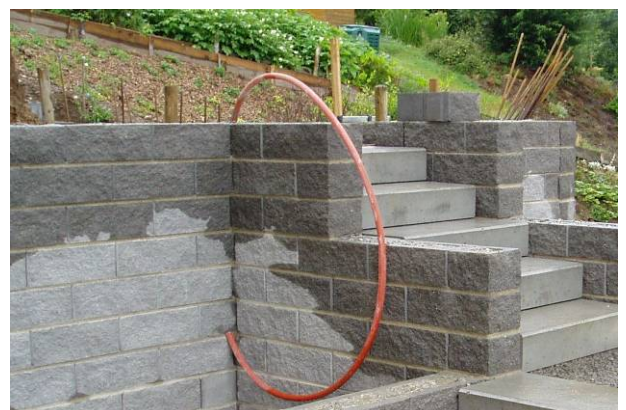
Bild 40: Einlegen der Leerrohre
