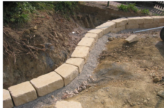
Bild 24: Versetzte erste Steinreihe in Kiesfundament
