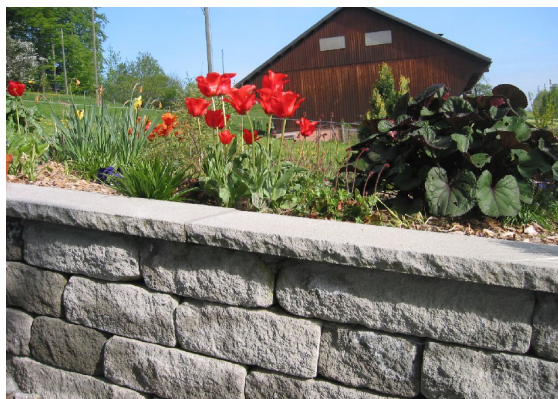
Bild 43: Versetzte SANTURO® Abdeckplatten
