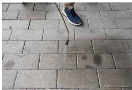
Reinigungsmittel auftragen
