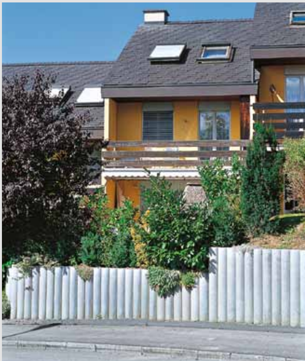
Beton-Palisaden als Hangsicherung.
