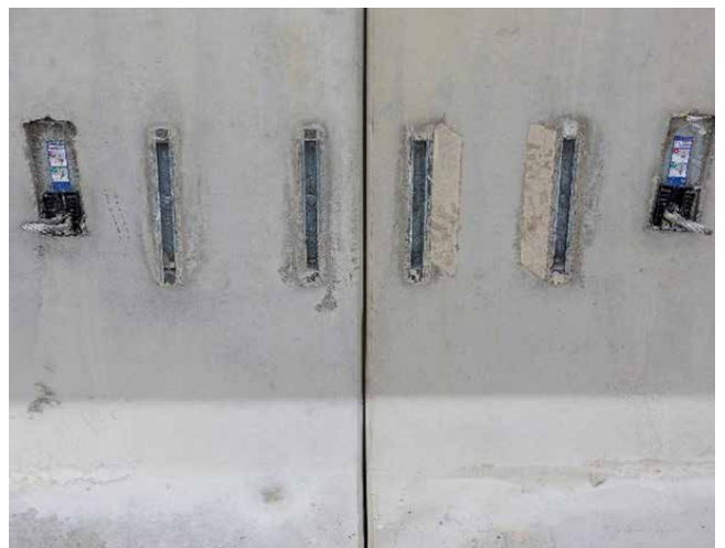
Halfenschienen als Verbindungsgrundlage
