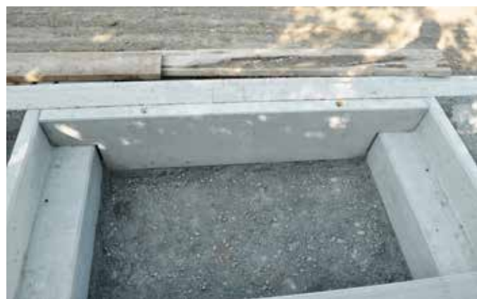
Versetztes F+F Abschlusselement
