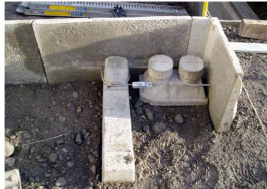
Bild 26a: Eckspanner parallel zum kleineren Schenkel montieren
