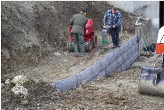
Bild 26: Verdichten der weiteren Schichten
