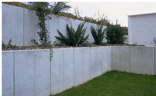
Bild 1: COMOFORTE® Winkelplatten als Böschungssicherung
