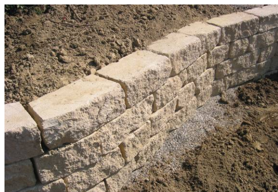
Bild 28: Kurvengbildung mit geraden Steinen
