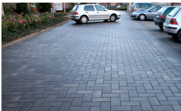
Bild 1: Pflasterdecke mit ECOPREC®-Bettungs- und Fugenmaterial
