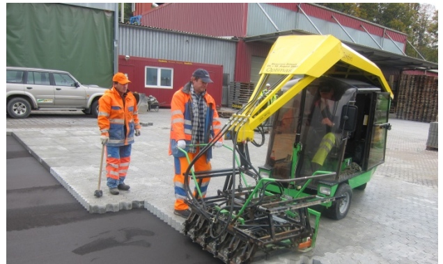
Bild 25: Maschinelle Verlegung
