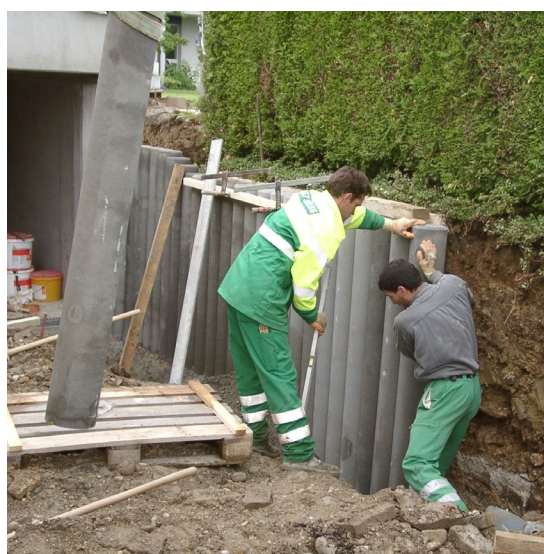
Bild 12: Versetzen und Richten von Palisaden
