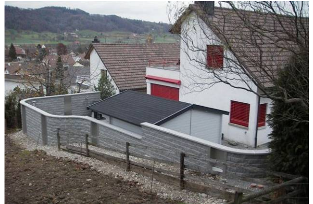
Bild 2: Doppelspaltsteine, eingesetzt als freistehende Mauer
