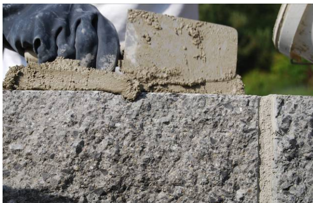
Bild 62: Erstellen der Mörtelvorlage
