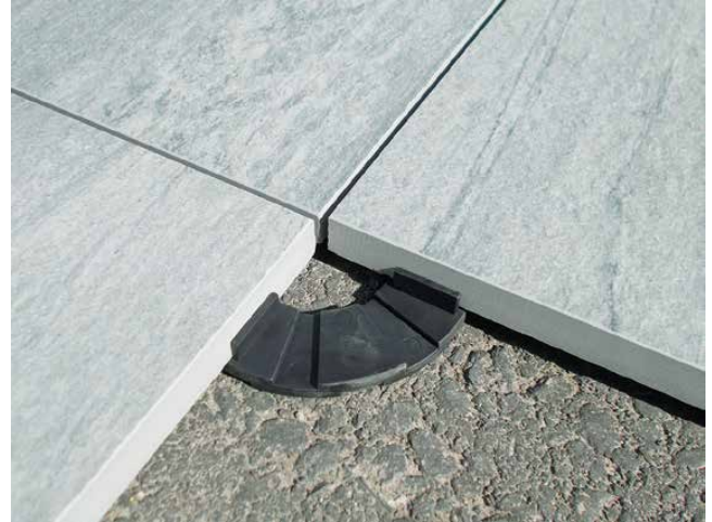
Bild 11: Verlegen der Feinsteinzeug Gehwegplatten auf Lagerringe
