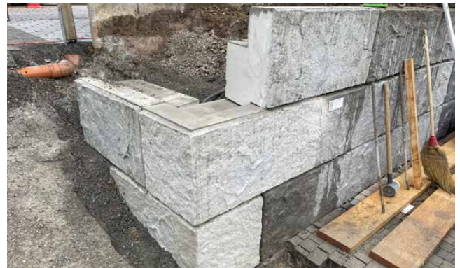
Bild 24 Versetzen der Eckelemente
