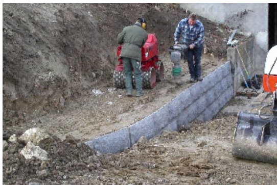
Bild 26: Verdichten der weiteren Schichten
