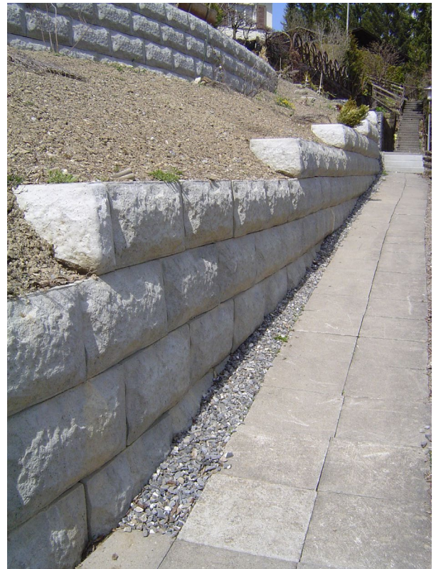
Bild 47: seitlicher Abschluss der Abtreppungen mit Ecksteine
