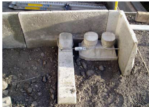
Bild 26a: Eckspanner parallel zum kleineren Schenkel montieren
