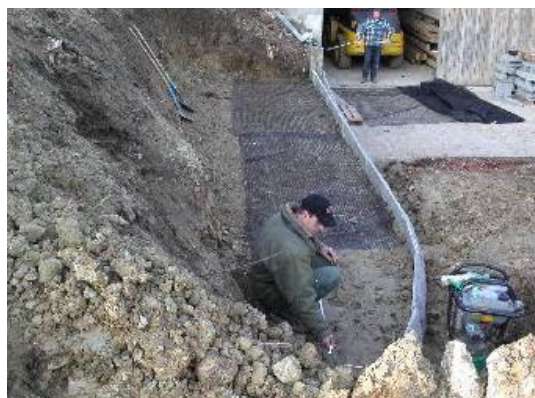
Bild 24: Verlegen der Geogitter, seitliche Überlappung 20 cm
