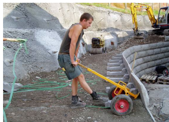
Bild 17: LOCK+LOAD Versetzwagen
