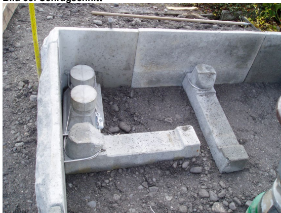
Bild 39: Eckstein mit Eckanker und -spanner
