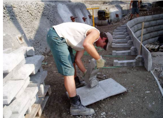
Bild 15: Frontplatte mit Anker verbinden
