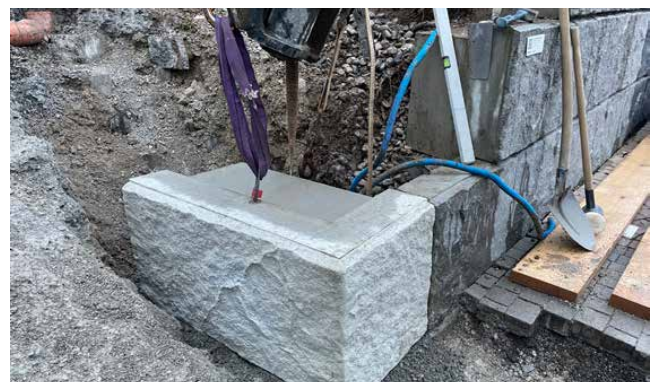
Bild 22 Anfangssteine mit Streifenfundament ohne Klebemörtel
