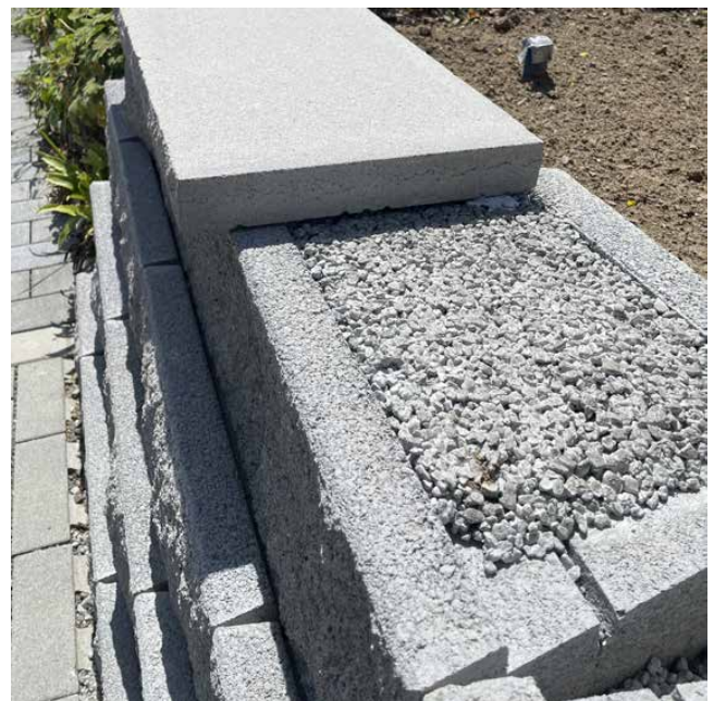
Bild 19: Versetzen von Abdeckplatten
