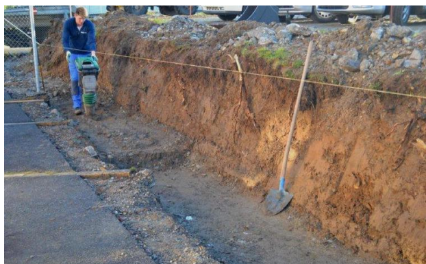
Bild 32: Erstellen der Sauberkeitsschicht
