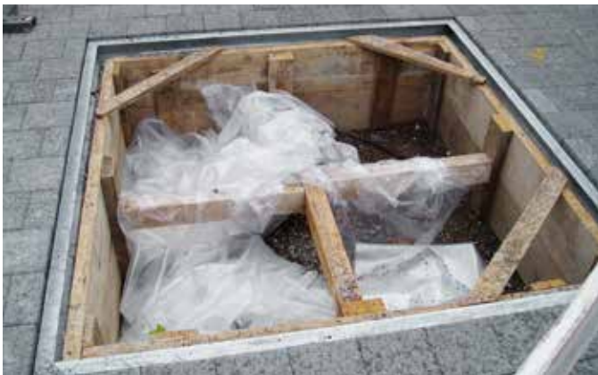
Eingebauter Stahlrahmen als Baumkranz
