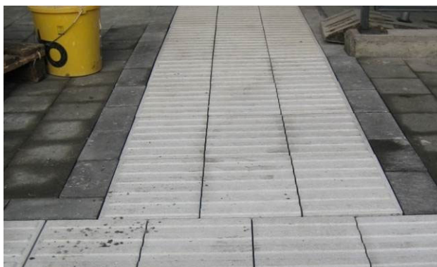
Bild 18: Anschluss Aufmerksamkeitsfelder an Sicherheitslinie
