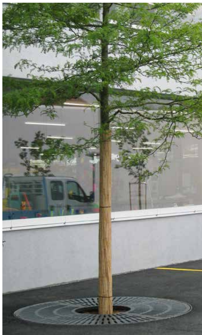
TREETUB Baumwurzelraumschutz mit Gussrost
