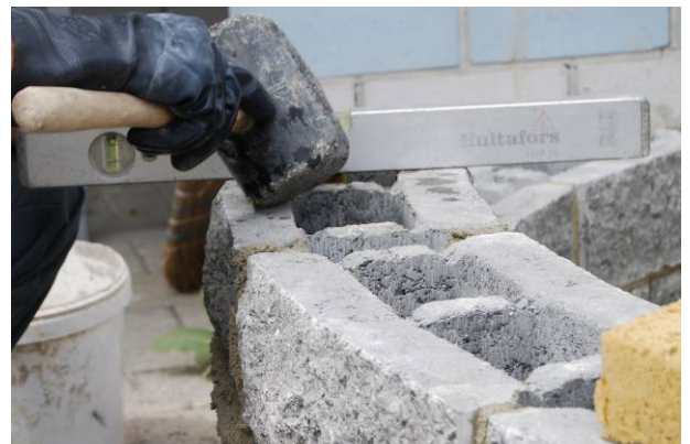
Bild 44: Richten und anklopfen des versetzten Spaltsteines
