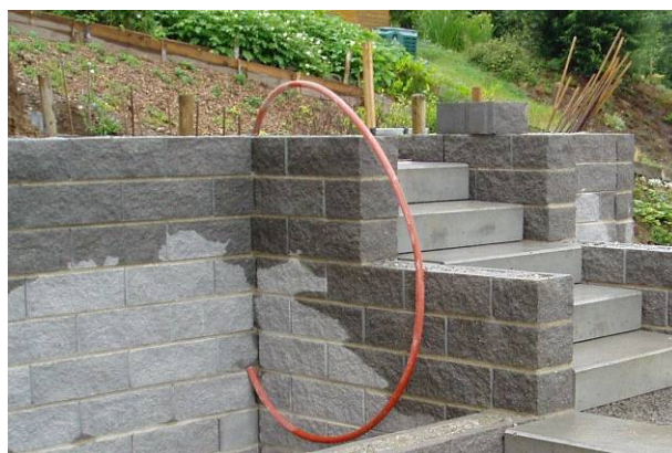
Bild 40: Einlegen der Leerrohre
