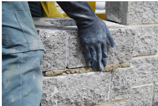
Bild 59: Versetzen von Pfeilerspaltsteinen
