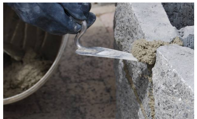
Bild 45: Entfernen von überschüssigem Mörtel
