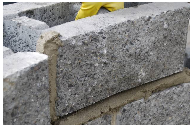
Bild 43: Versetzen des Mauersteines auf die Mörtelschicht
