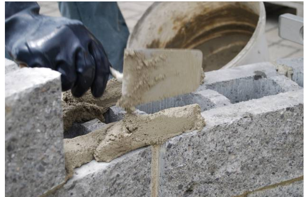
Bild 42: Aufbringen der Mörtelschicht
