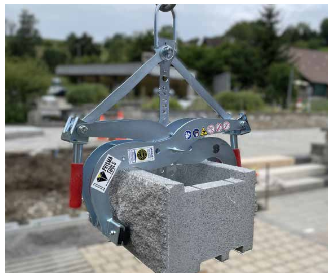
Bild 5: Versetzen mit Trittstufenversetzzange TSZ-Uni
