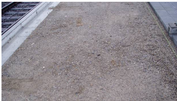
Bild 23: Eingebaute Fundamentsschicht
