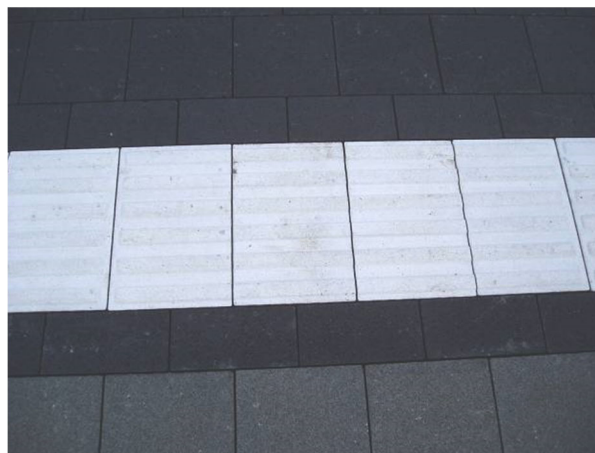
Bild 25: Optimale Fugenbreite
