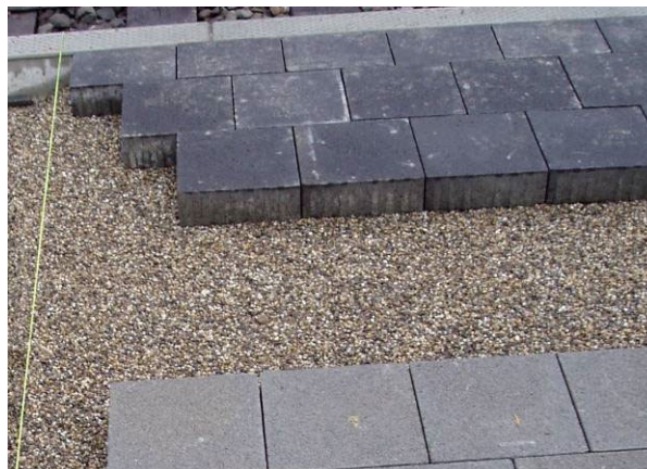
Bild 24: Eingebaute Bettungsschicht
