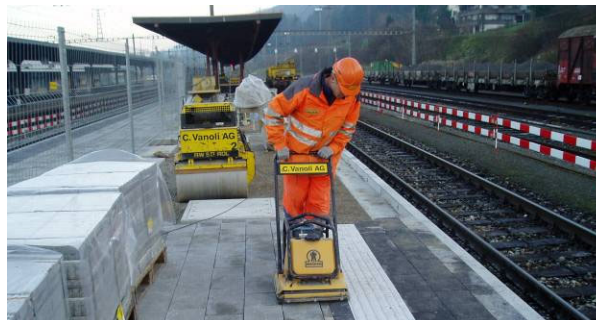
Bild 28: Einsatz eines Flachrüttlers
