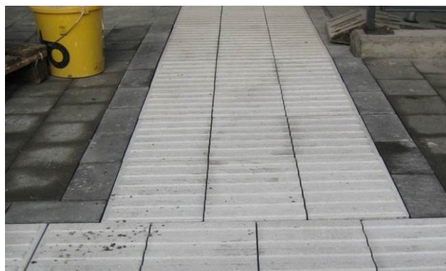
Bild 18: Anschluss Aufmerksamkeitsfelder an Sicherheitslinie
