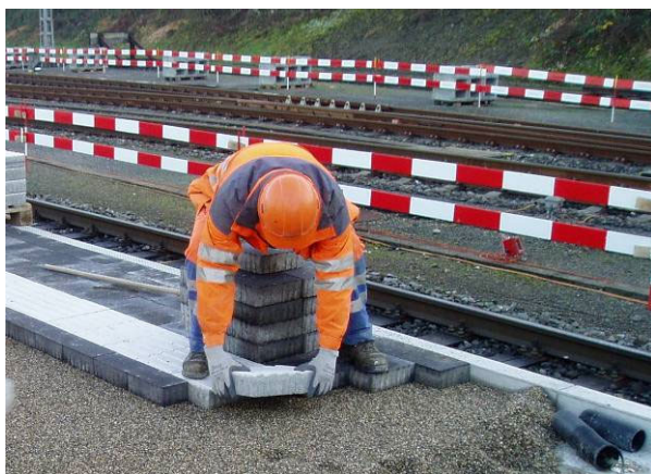
Bild 26: Verlegen von CARENA® Sicherheitsliniensteine H = 8 cm
