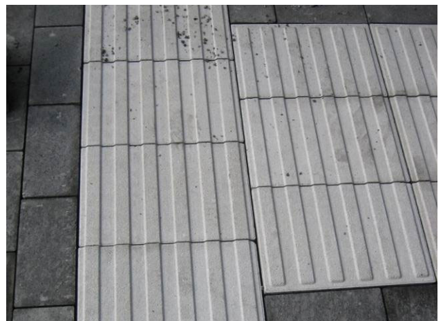
Bild 34: Optimale Fugen bei Steinen H = 8 cm
