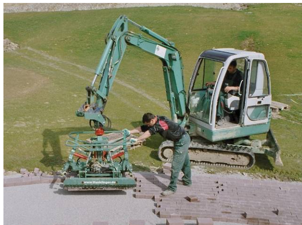
Bild 38: Verlegemaschine im Einsatz
