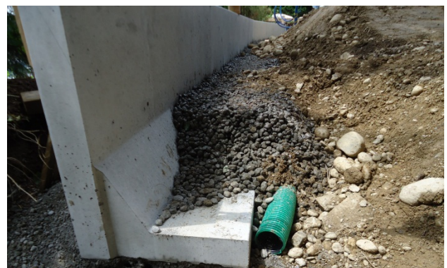
Bild 24: Einbau einer Sickerleitung
