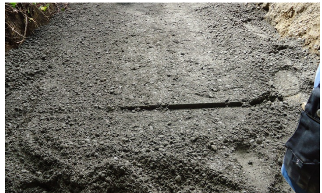
Bild 23: Erstellen des Streifenfundamentes
