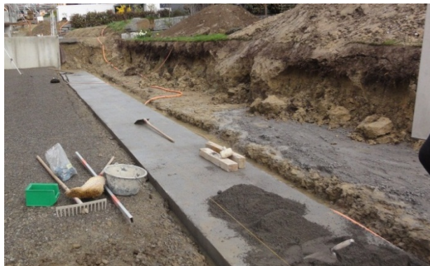
Bild 27: Erstelltes Streifenfundament
