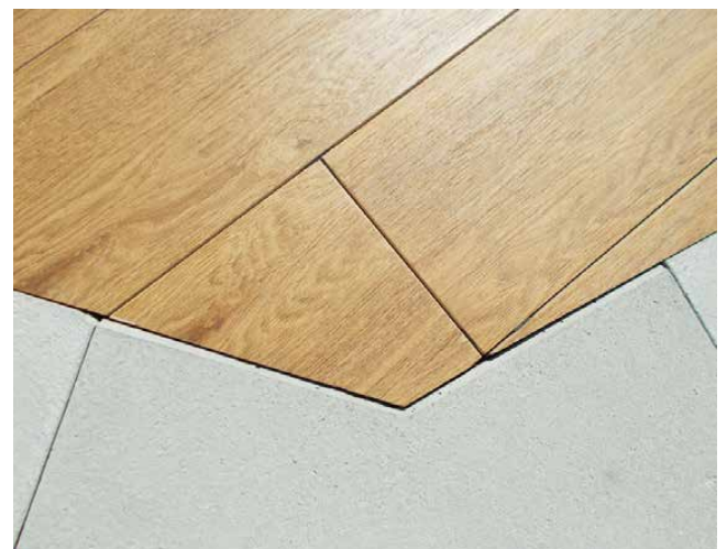
Bild 8: Passstück Feinsteinzeug Gehwegplatte
