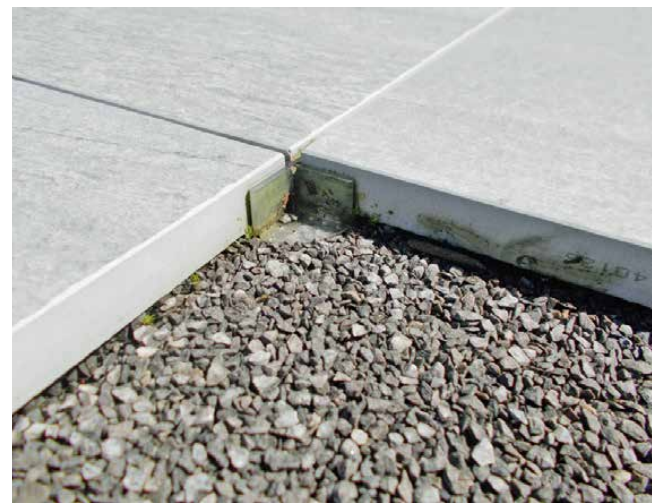
Bild 7: Verlegen der Feinsteinzeug Gehwegplatten in Bettungsschicht
