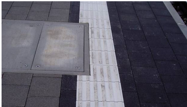
Bild 30: Anpassungen der CARENA® Sicherheitsliniensteine bei Schachtabdeckungen
