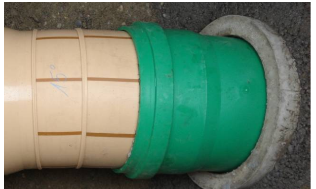
Bild 15: Angeschlossenes Anschlussrohr
