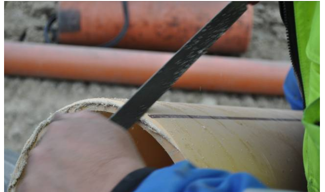
Bild 14: Anfasen des Kunststoffrohres, reinigen und einschmieren
