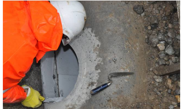
Bild 10: Klebmasse auf die Bohrlochwandung auftragen
