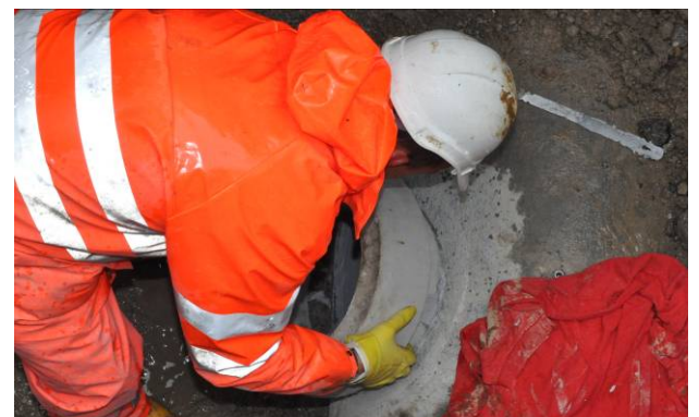
Bild 11: Klebeanschlussstück mit einer Drehbewegung einsetzen
