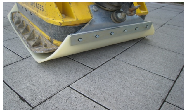
Bild 29: Abrütteln der Pflasterdecke
