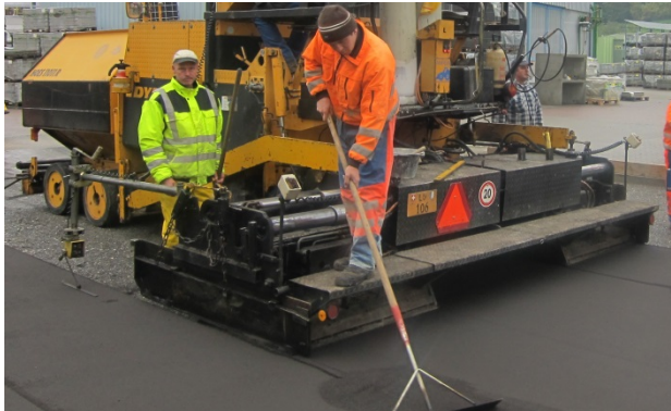
Bild 14: Einbau mit Asphaltfertiger
