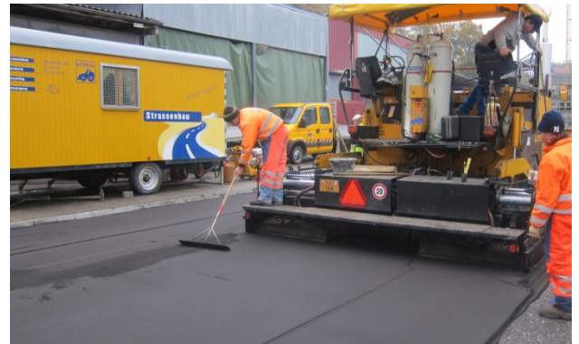
Bild 2: Einbau von ECOPREC®-Bettungsmaterial
