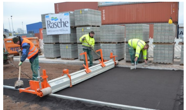
Bild 19: Mischgut abziehen
