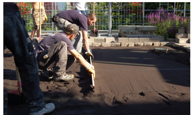
Bild 18: Mischgut abziehen
