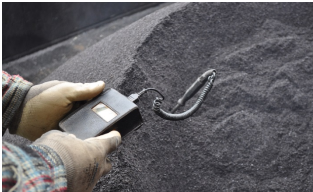
Bild 20: Kontrolle der Einbautemperatur
