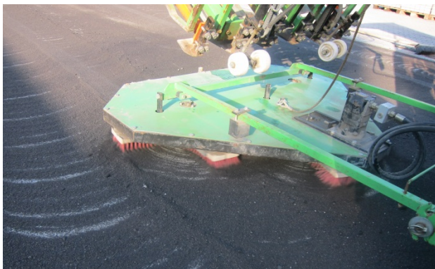
Bild 27: Maschinelles Einbringen des ECOPREC®-Fugenmaterials
