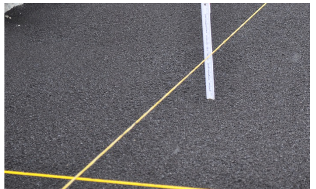
Bild 22: Kontrolle der Einbauhöhe
