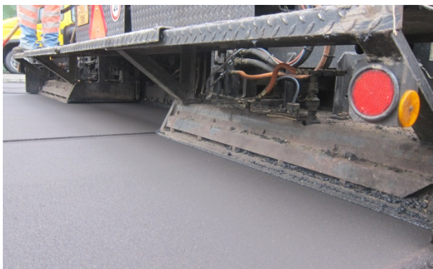
Bild 15: Rüttelbohle darf das Material nur anziehen
