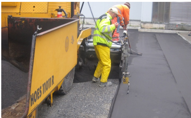
Bild 16: Nahtflanken sind abzukanten
