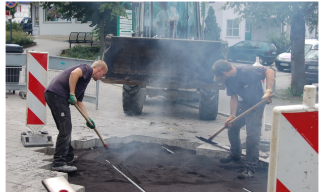
Bild 17: Mischgut muss gesetzt werden
