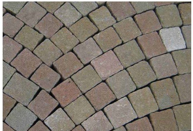
Verlegte FRIEDA® Pflastersteine für eine Segmentpflasterung
