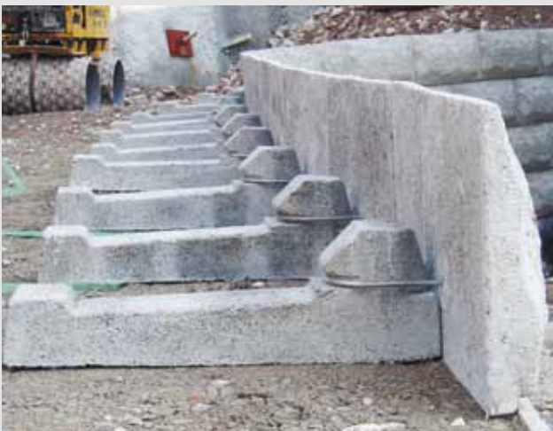
Frontplatten mit Erdanker
