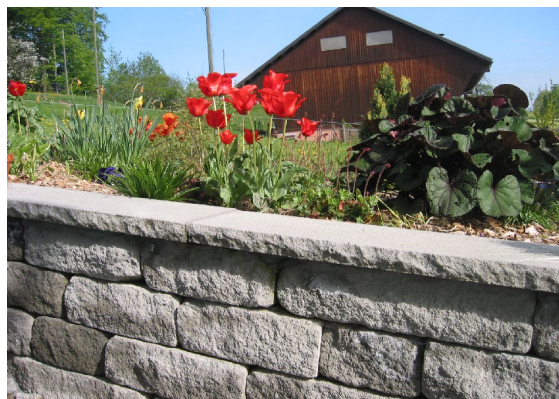
Bild 43: Versetzte SANTURO® Abdeckplatten
