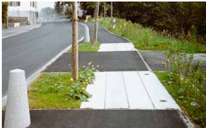
Wurzelbrücke mit Wehrsteinen als Anfahrtschutz
