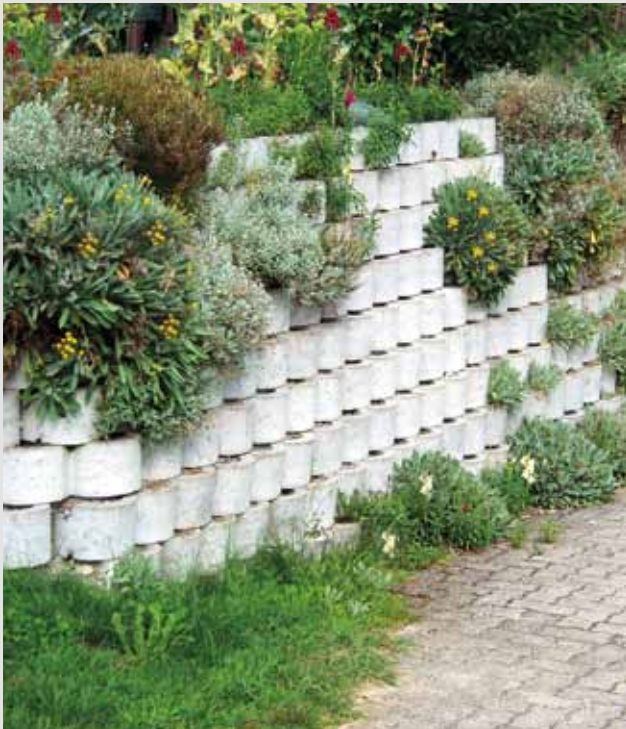
Begrünbare (offene) Hangsicherung
