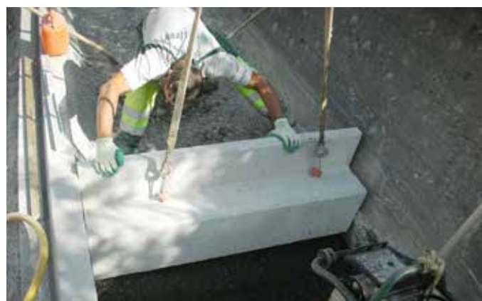
Versetzen des F+F Fertigfundamentes
