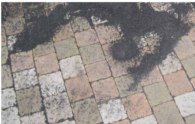
Einsanden der Fugen
