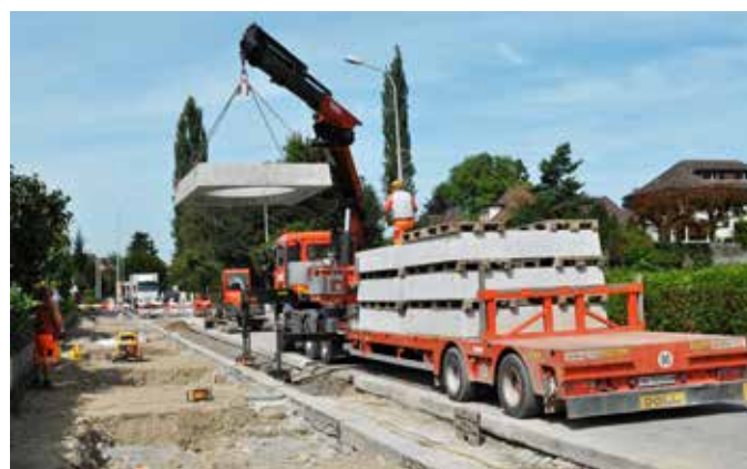
Transport auf der Baustelle mit Lieferfahrzeug
