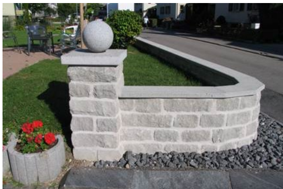
Bild 44: Versetzte SANTURO® Abdeckplatten in Segmente geschnitten
