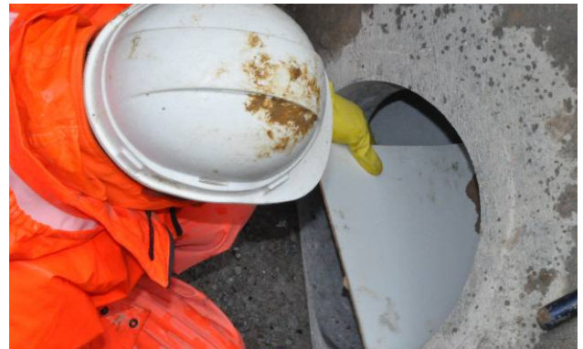
Bild 8: Einlegen einer Unterlage
