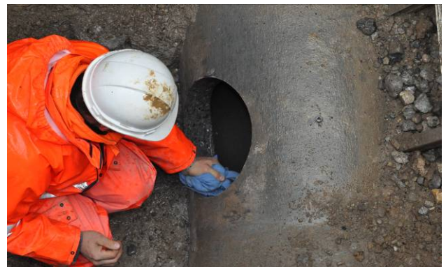
Bild 7: Bohrloch reinigen
