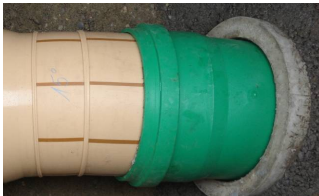
Bild 15: Angeschlossenes Anschlussrohr
