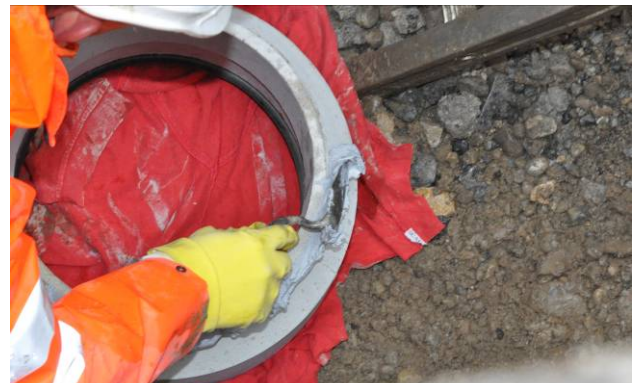
Bild 9: Auftragen der Klebmasse auf den Schaft
