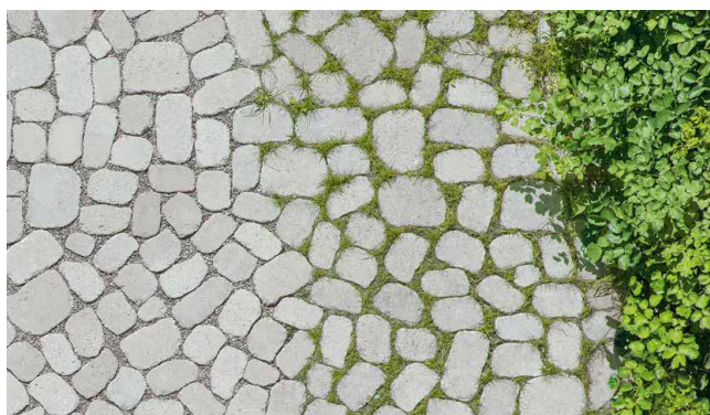
Bild 7: Fugenbefüllung Splitt und Begrünt
