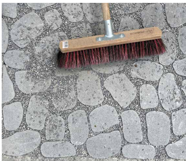
Bild 6: Einsanden der Fugen
