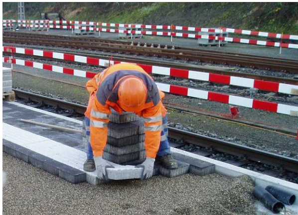
Bild 26: Verlegen von CARENA® Sicherheitsliniensteine H = 8 cm
